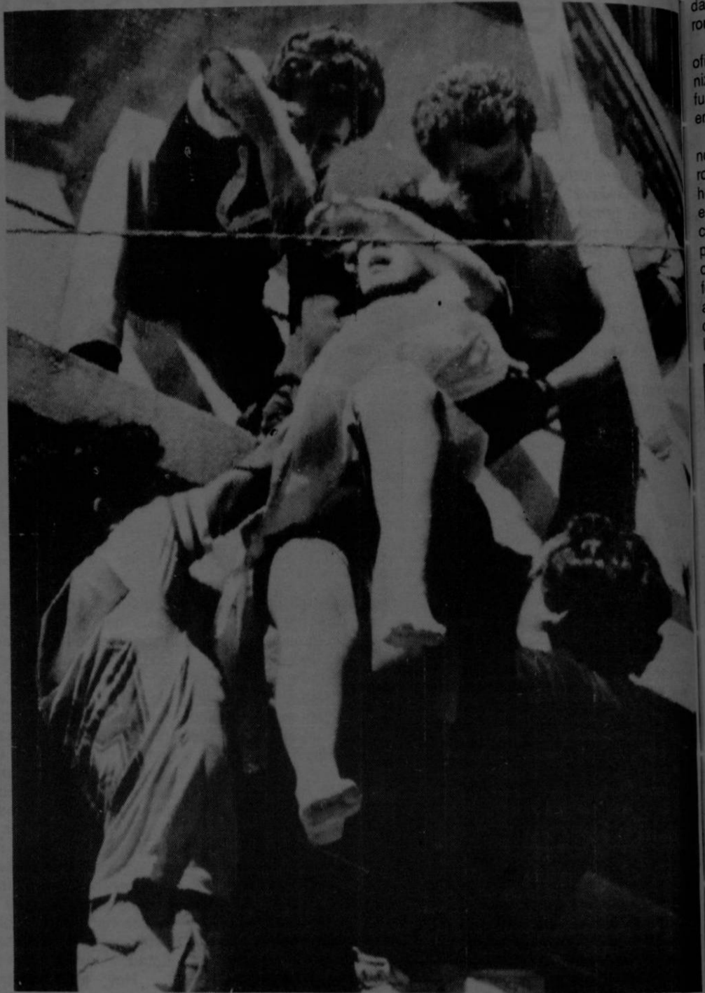
Entre las ruinas del edificio Rubén Darío, que ayer todavía se derrumbó más por los movimientos secundarios que persisten, los voluntarios sacan a una mujer herida. (AP)
